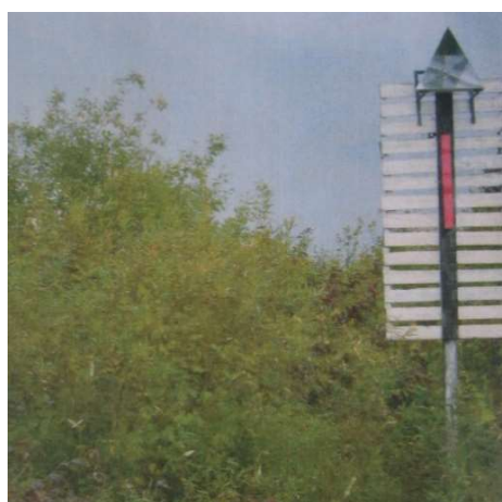
Рис. 2. Радиооптический групповой отражатель кругового действия
